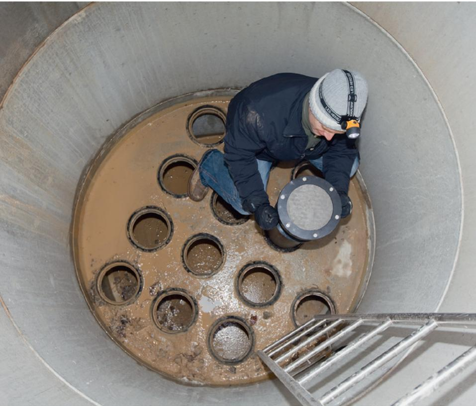
Einsetzen der Filterpatronen mit Eisenhydroxid und Kalksand am Grund des Regenwasserschachts.
